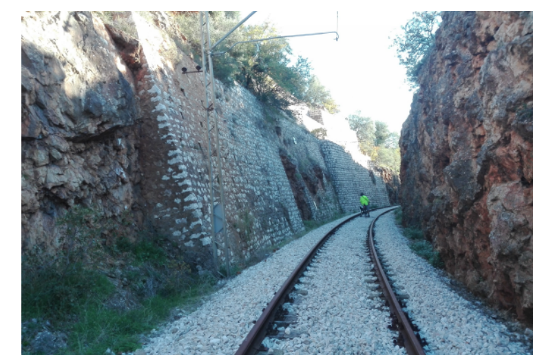
f.6: Tratto in trincea
