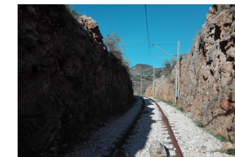
f.7: Tratto in trincea con entrambe le pareti in roccia viva
