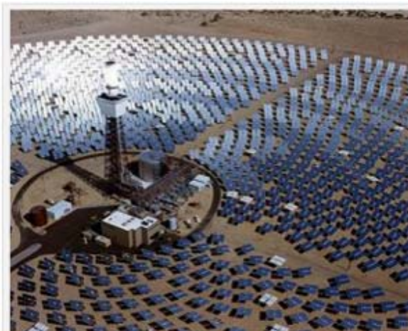
Figura 144 – Centrale termodinamica a torre a Barstow – California (USA)
