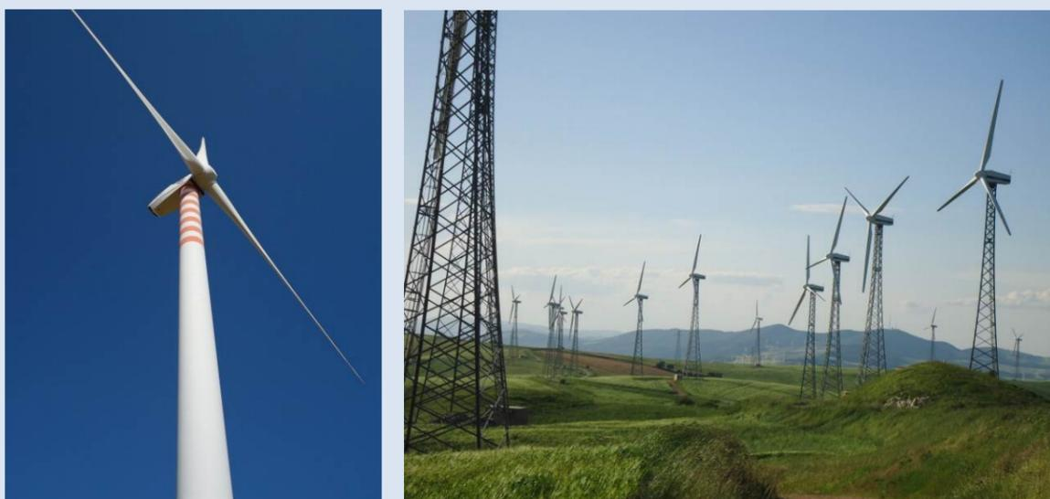
*Fig. 37: Provincia di Foggia (foto di Raffaella Laviscio):* nel territorio della provincia di Foggia coesistono impianti con macchine a struttura trilitica e tubolare. Le macchine a struttura trilitica sono generalmente quelle più vecchie e, dunque, più contenute nelle dimensioni. Oggi si preferiscono, tuttavia, macchine tubolari che consentono l'installazione al loro interno anche delle cabine elettriche.
