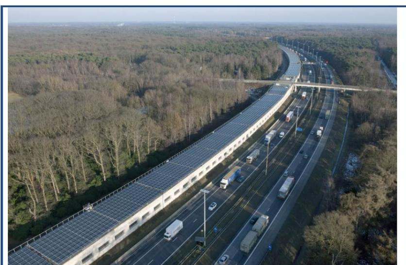
*Fig. 51. Scelte di localizzazione, rete ferroviaria di Anversa (www.ecologiae.com): nell'ambito del progetto denominato "Solar Tunnel", su un tunnel della rete ferroviaria ad alta velocità di Anversa è stato progettato e realizzato un mega-impianto fotovoltaico composto da ben 16 mila pannelli che alimenta i treni e l'infrastruttura ferroviaria. L'impianto ha un'estensione di 50.000 mq e avrebbe certamente un notevole negativo impatto paesaggistico in una localizzazione non altrettanto idonea.*
