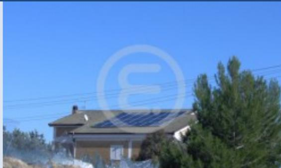
*Fig. 81. Foggia (www.enermea.com):* su tetti a falda inclinata i pannelli dovranno essere montati mantenendo la stessa inclinazione della superficie che li accoglie. La riduzione al minimo dello spessore dell'impianto e delle strutture accessorie garantisce una buona integrazione, come nel caso in figura.
