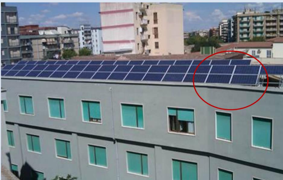
*Fig. 64 Foggia (www.energysunproject.com):* i pannelli disposti sul tetto piano non seguono, nella disposizione, la forma propria dell'edificio compromettendone la percezione unitaria.
