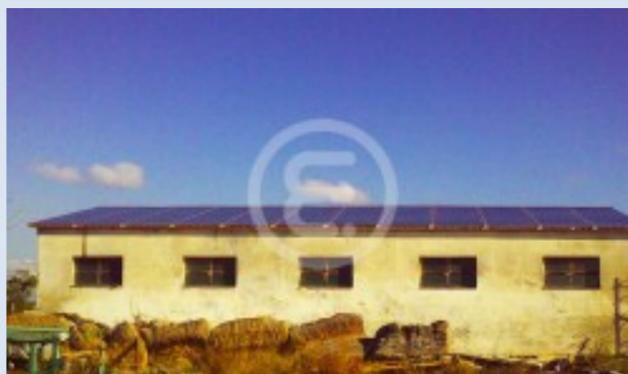
*Fig. 86. Foggia (www.enermea.com):* anche in questo caso, nonostante la complanarità delle superfici, il distacco cromatico tra i pannelli fotovoltaici e il supporto costituito dalla copertura in coppi crea effetto di discontinuità. Le attuali tecnologie consentono, in una progettazione accorta, anche la scelta di cromie diverse e adeguate ai diversi contesti.
