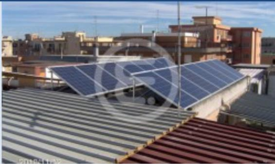
*Fig. 80. Foggia (www.enermea.com):* la collocazione su tetto piano non può avvenire senza opportuna schermatura dei pannelli, inclinati per esigenze tecniche, mediante la creazione di elementi perimetrali (parapetti, cornicioni). I moduli, diversamente che in questo caso, non dovranno sporgere per più di metà della porzione più bassa dell'elemento perimetrale.
