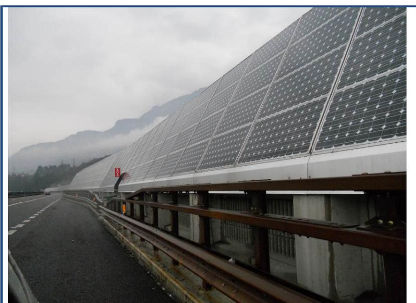
*Fig. 52. Scelte di localizzazione, autostrada del Brennero (foto di Raffaella Laviscio): pannelli fotovoltaici sostituiscono quelli tradizionalmente utilizzati per la realizzazione di barriere antirumore in un tratto di qualche chilometro*
