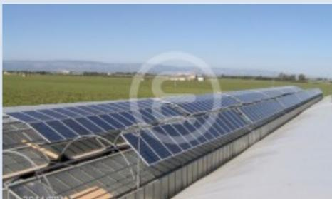
*Fig. 57.: Foggia (www.enermea.com): capannoni industriali, capannoni agricoli e serre di nuova costruzione consentono l'inserimento integrato di impianti fotovoltaici di notevoli dimensioni evitando l'ulteriore occupazione di suolo agricolo.*
