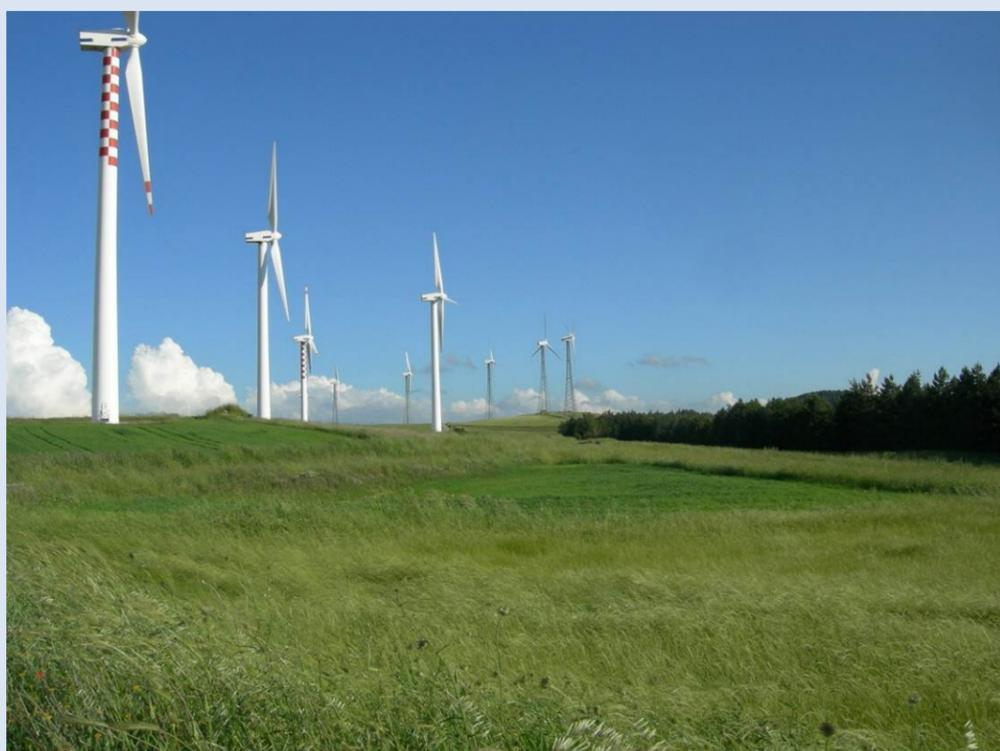
*Fig 38: Provincia di Foggia (foto di Raffaella Laviscio):* è opportuno che ogni singolo parco eolico presenti uniformità nella scelta di dimensioni, forma e colori garantendo, in tal modo, la leggibilità dell'intervento come progetto unitario. Anche nel caso di impianti diversi, ma prossimi è necessario che l'intervento più recente tenga conto delle caratteristiche delle macchine già presenti.
