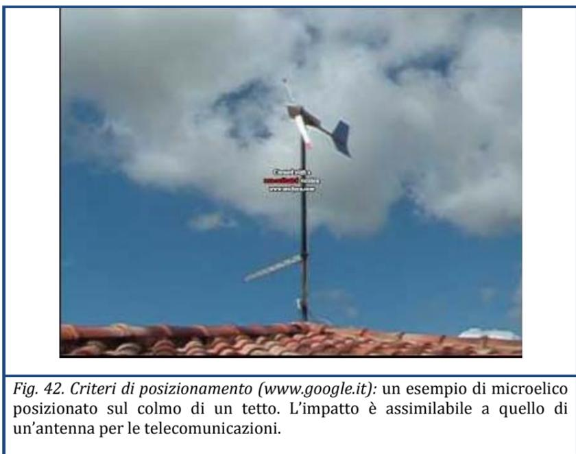
Fig. 42. Criteri di posizionamento ([www.google.it](http://www.google.it)): un esempio di microeolico posizionato sul colmo di un tetto. L'impatto è assimilabile a quello di un'antenna per le telecomunicazioni.
