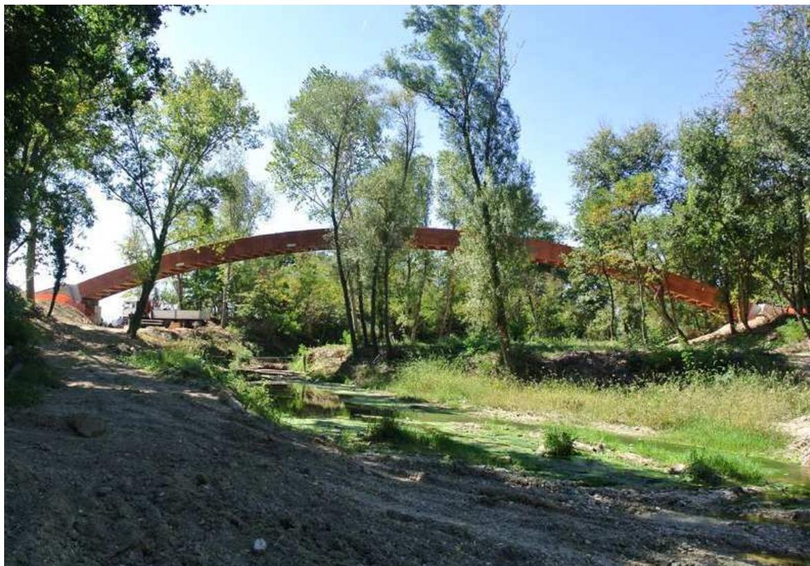
Il costo di installazione di una passerella (ponte ciclopedonale) di luce medio-piccola della larghezza di 2,5 metri può variare a seconda della tipologia (a trave, ad arco, strallata, ecc.) e della lunghezza che influisce sulle modalità di messa in opera dei manufatti che possono essere prefabbricati o assemblati in loco. Le caratteristiche del sito e del contesto possono influire sulla progettazione e sui lavori preparativi. Il costo parametrico assunto è di 9.000 euro al metro lineare.
