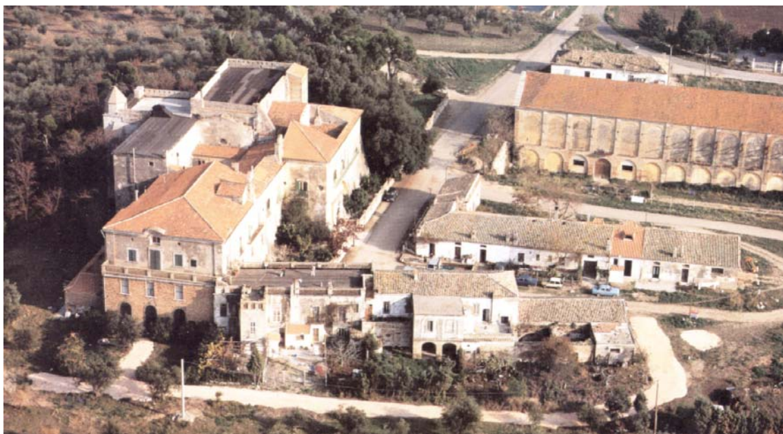
Lesina, complesso architettonico di Santa Maria di Ripalta (foto da Capitanata Medievale, a cura di M. S. Calò Mariani)
