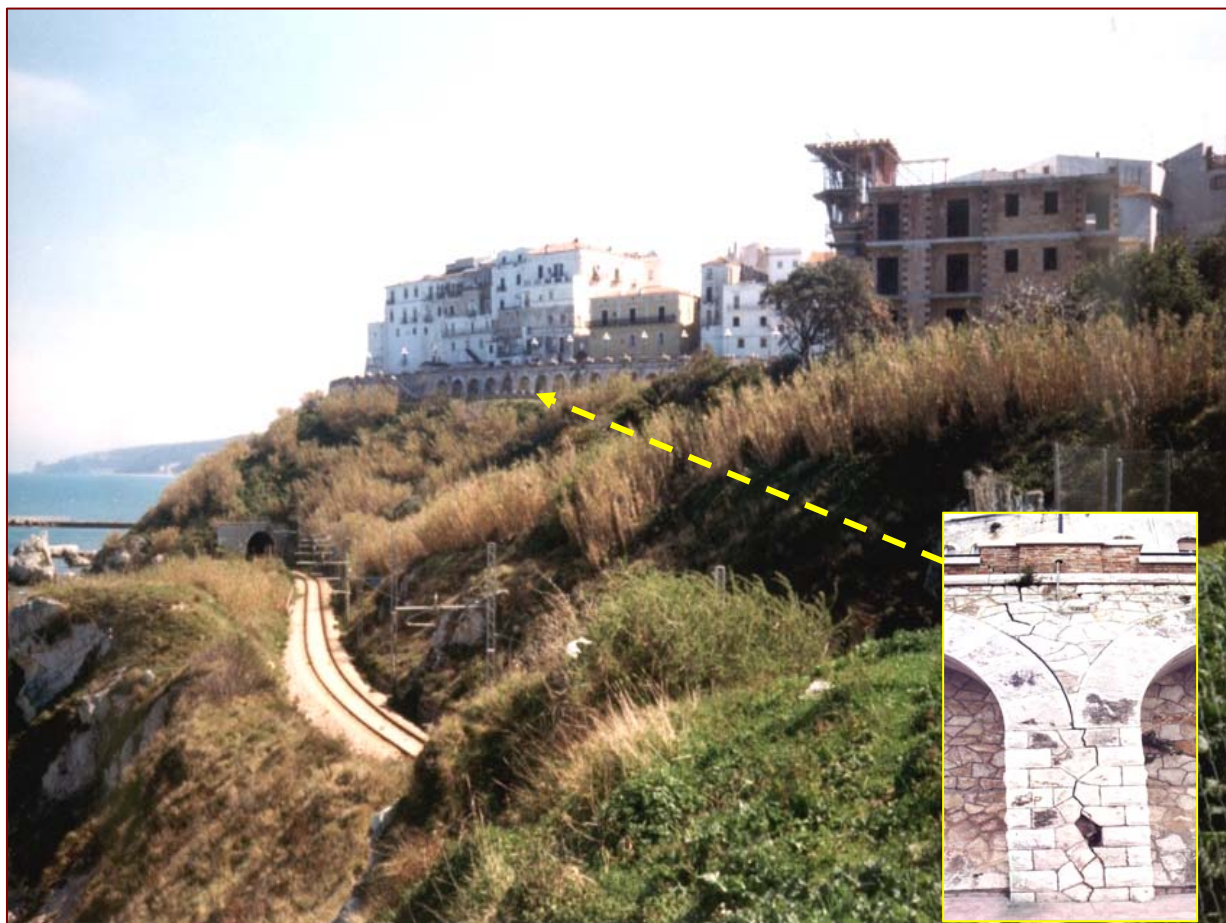
Fig. 129 - Rodi Garganico - La frana che coinvolge il Rione Camomilla incombe su di un tratto della Ferrovia Circumgarganica
