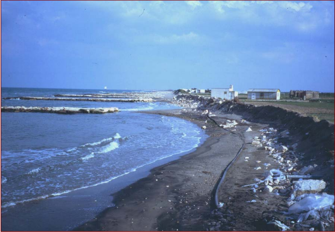
Fig. 152 – Il mare, sfondando le difese (in genere gabbionate di tipo tradizionale, i cui resti sono visibili ai piedi della piccola scarpata di destra), riconquista terreno asportando con facilità il materiale di colmata con cui era stato bonificata la costa di Zapponeta.
