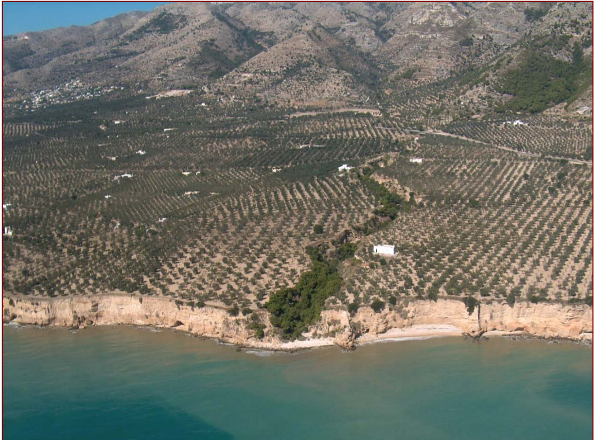
Foto 126 – Costa alta a conoidi in località Vallone dei Porci (Foto Caldara, 2005)
