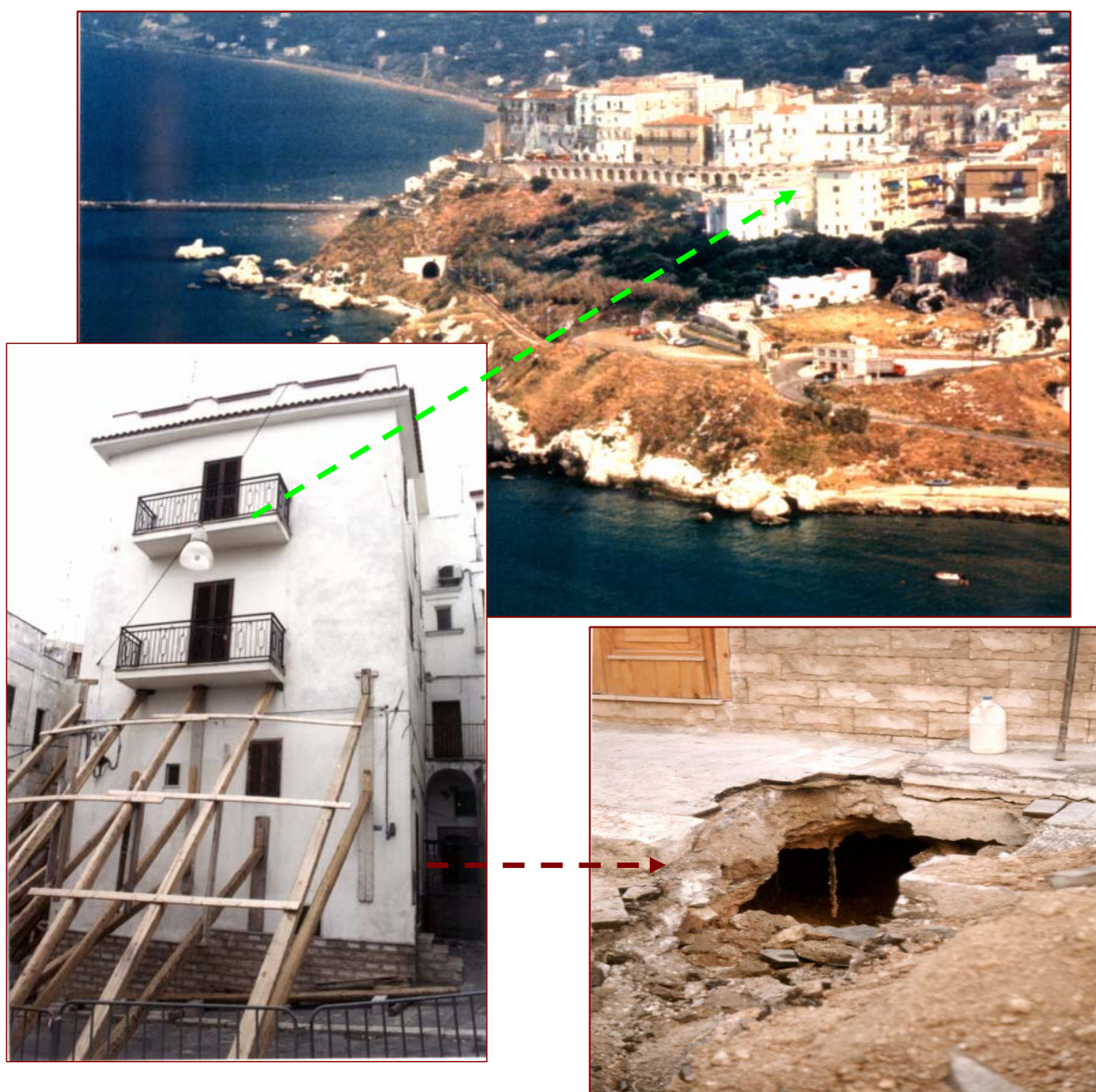
Fig. 145 - Particolari della frana che coinvolge il Rione Camomilla a Rodi Garganico
