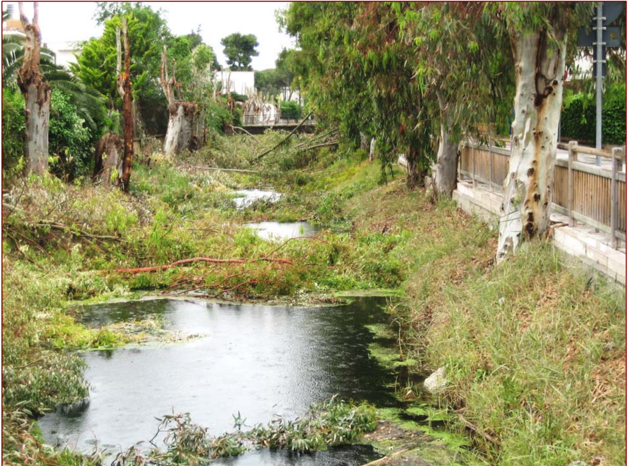
Fig. 167-168 – Questo è lo stato dei canali che dovrebbero allontanare le acque dall’abitato di Apricena. (Foto E. Laltrel-
