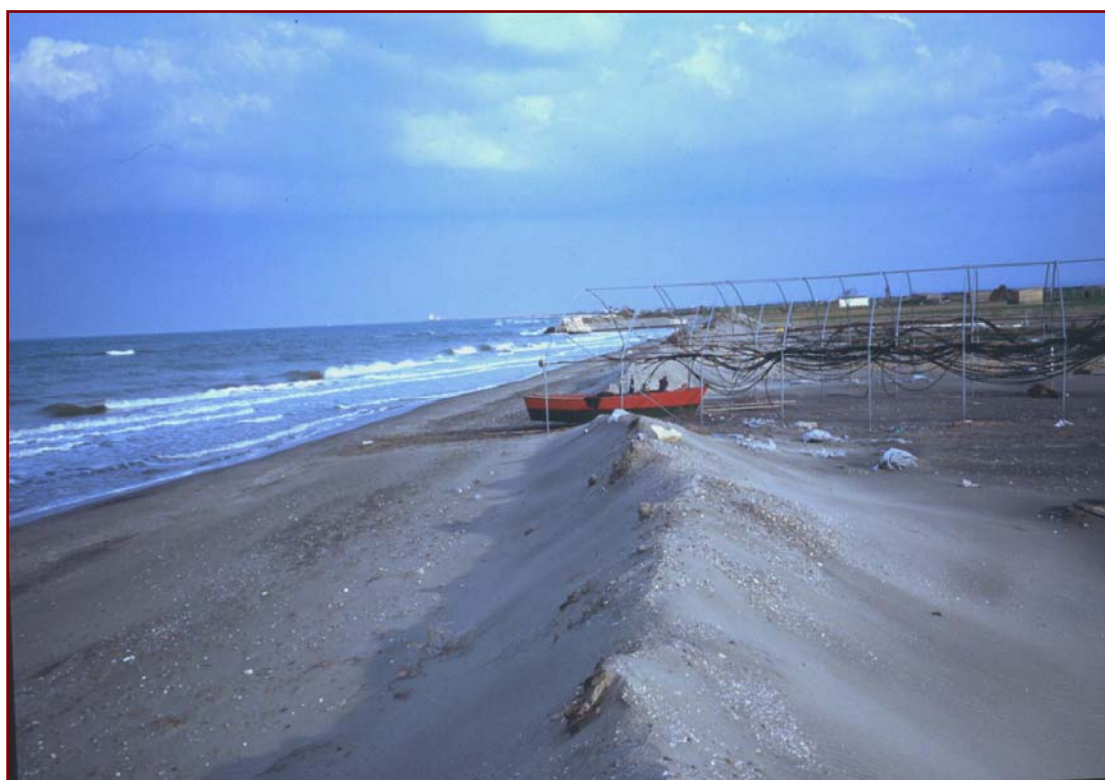
Fig. 151 – L'entro-terra di Zapponeta fu bonificato ed artificialmente sollevato con materiale di riporto a + 0,60 m s.l.m. (Foto di M. Caldara, 2002)
