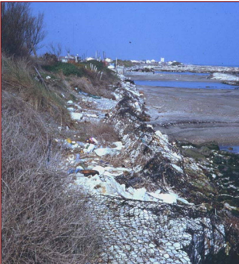
Fig. 153 – Il mare ha ormai raggiunto la seconda linea di gabbionate (in primo piano). Si osservi, in alto a destra, ciò che resta della prima linea di difesa. (Foto di M. Caldara, 2002)
