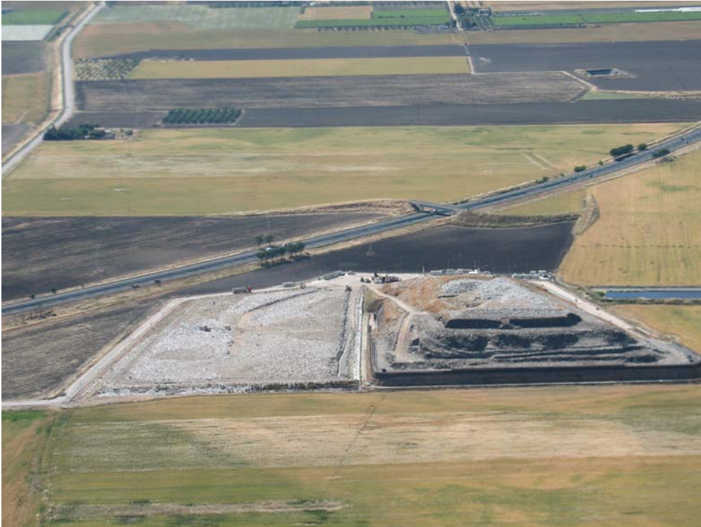
Figure 3.4.2.2.a Ripresa aerea della discarica di rifiuti solidi urbani ubicata a sud della zona industriale di Foggia [foto di G. Bogliani].
