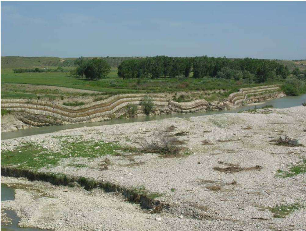
Fig. 3.4.4.b – Dissesto provocato da opere di sistemazione idrauliche
